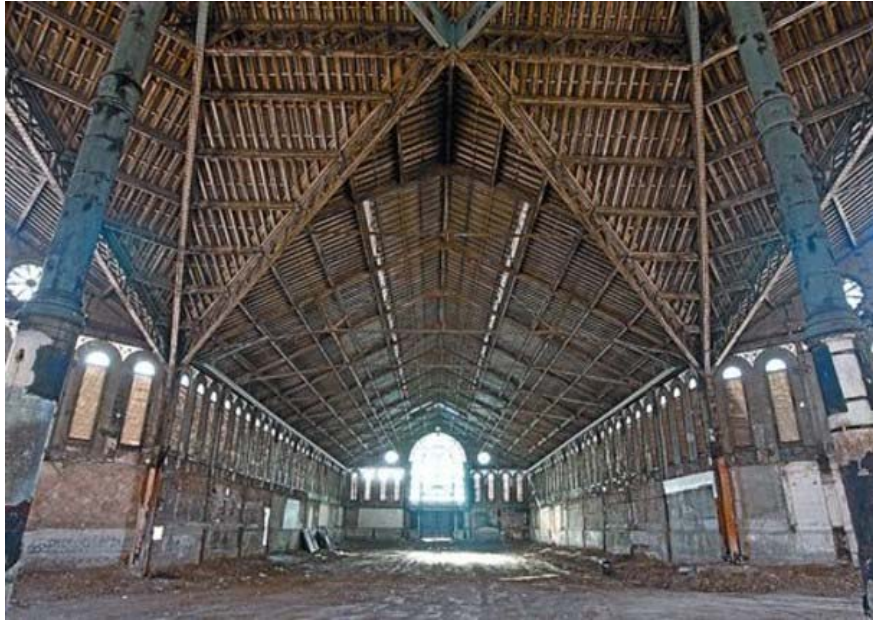
El interior del mercado de Sant Antoni, ya despejado a punto de afrontar nuevas obras, ayer. DANNY CAMINAL
